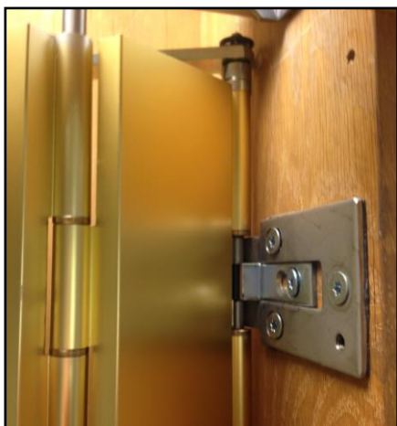
Figur 11. Monterat gångjärn vid avslutande halvsektion
