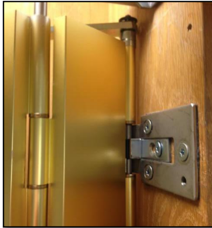
Abbildung 9 - Montiertes Scharnier am Ende des halben Abschnitts.
